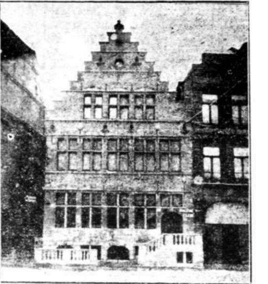
DOORNIK, CENTRUM VAN KUNST EN SPORT Het nieuwe lokaal van de 'Racing Club' van Doornik, op de Grote Markt, dat doedig geprojecteerd. — Dit huis, opgetrokken in Vlaamse stijl, en aanjukt het plein in een eigenaardige van de plaats.
